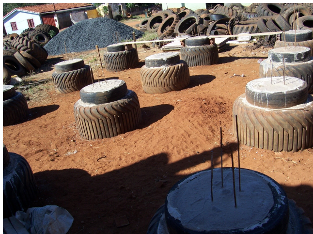
Figura 9 – Fundação em sapata utilizando a carcaça de pneu.
