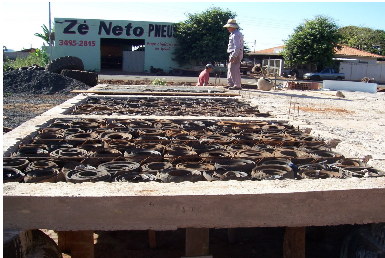
Figura 11 – Preparo da laje de forro para concretagem.
