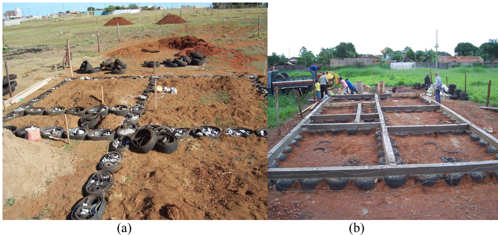
Figura 8(a e b) – Execução da fundação para habitações térreas.
