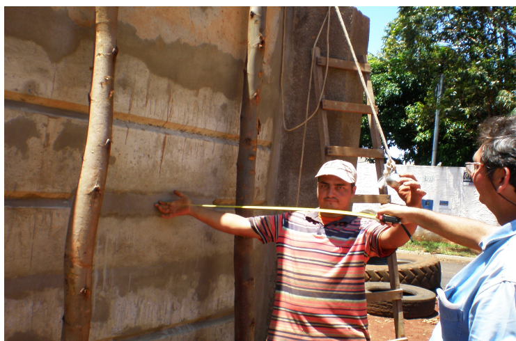
Figura 4 – Teste de impacto de corpo duro no lado externo da parede.
