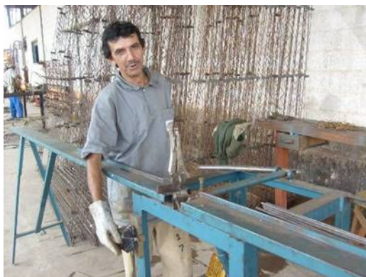
Figura 12: Corte e dobra de armaduras.
