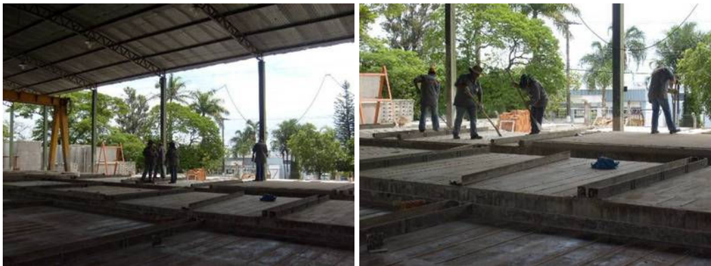
Figura 23: Limpeza das bancadas de concreto com as formas já montadas.
