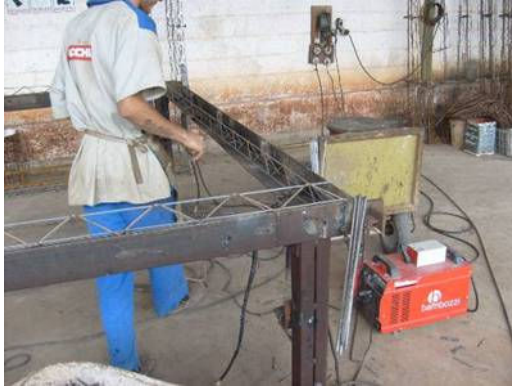
Figura 14: Montagem das treliças e nervuras dos painéis.
