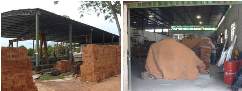
Figura 5: Armazenamento de blocos e de argamassa.
