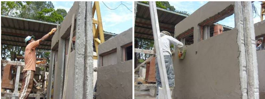
Figura 30: Painel na vertical sendo revestido em outra face.
