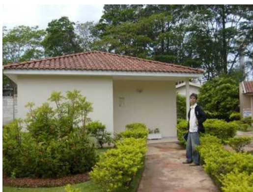
Figura 33: Fachada de casa construída pelo sistema Jet Casa.
