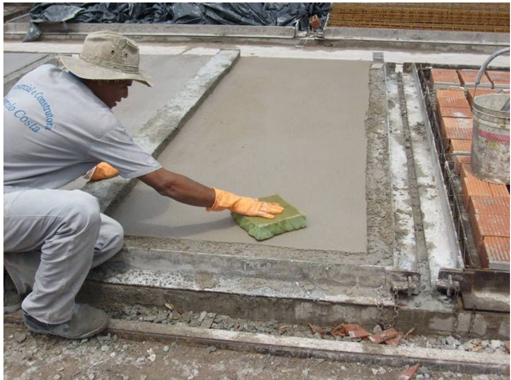
Figura 27: Painel parede com uma das faces revestidas.
