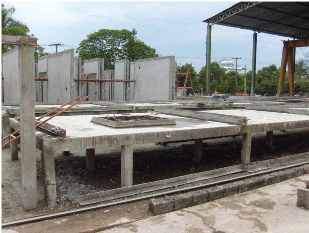
Figura 24: Bancada de concreto com forma e batentes já inseridos.
