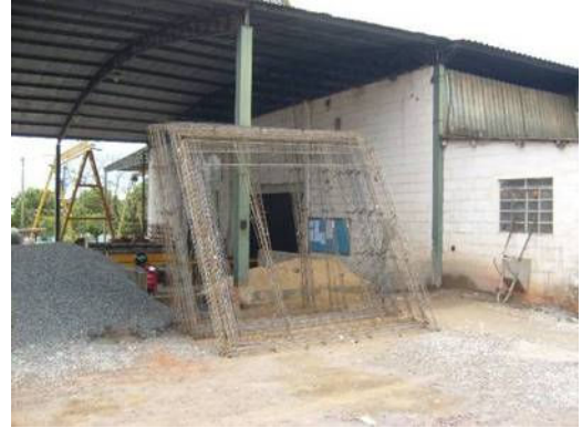
Figura 15: Armaduras prontas para serem colocadas nas formas.
