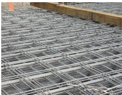
Figura 32: Malhas usadas nas lajes pré-moldadas Jet Casa.
