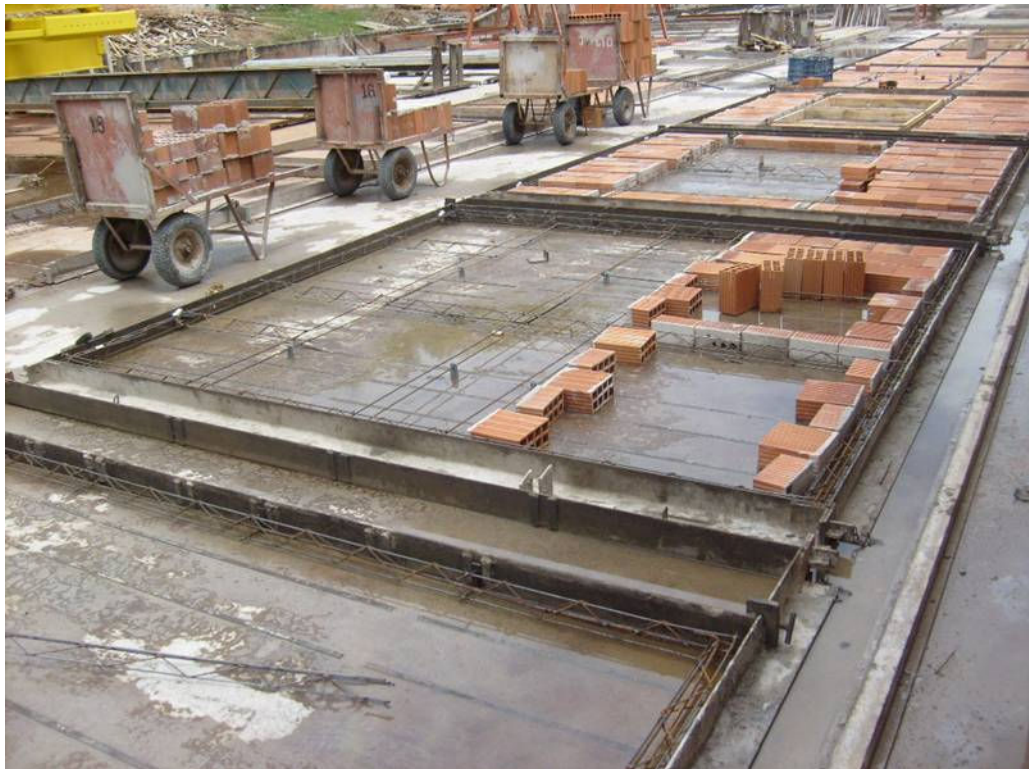
Figura 16: Forma com armadura já montada e posicionada.
