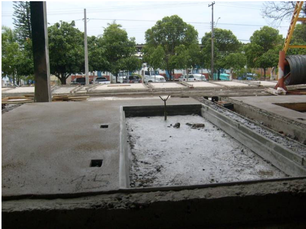
Figura 21: Painel parede revestido em uma das faces mostrando as saídas de elétrica e o batente da esquadria.
