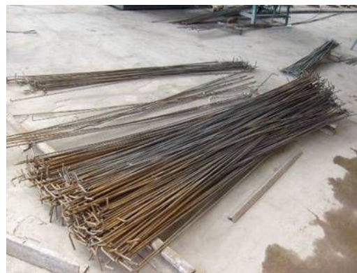
Figura 13: Barras cortadas e dobradas para serem unidas às treliças.
