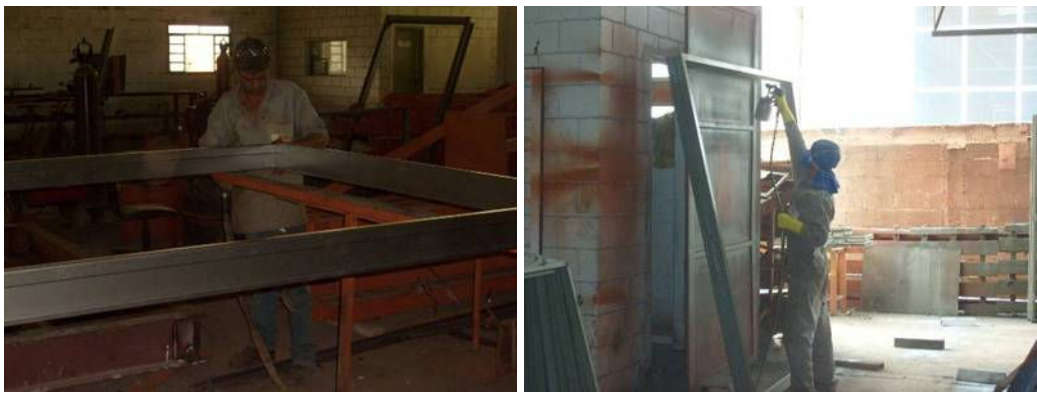
Figura 22: Fabricação e pintura anticorrosiva das formas.
