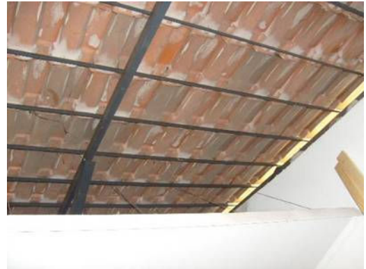
Figura 37: Recorte no forro mostrando a cobertura.
