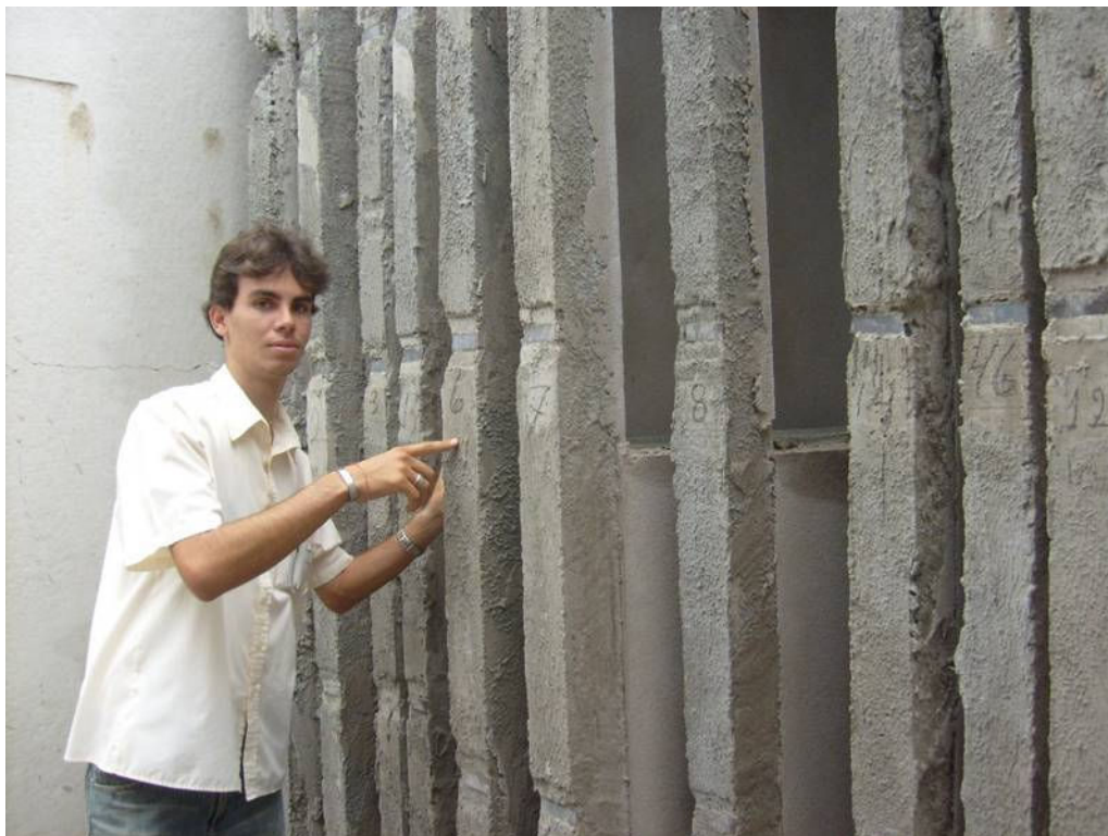
Figura 31: Estocagem dos painéis prontos e numerados para serem transportados ao local final da obra.
