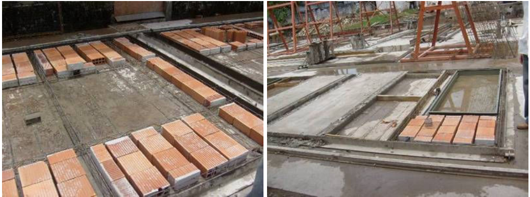
Figura 25: Blocos sendo colocados na forma.
