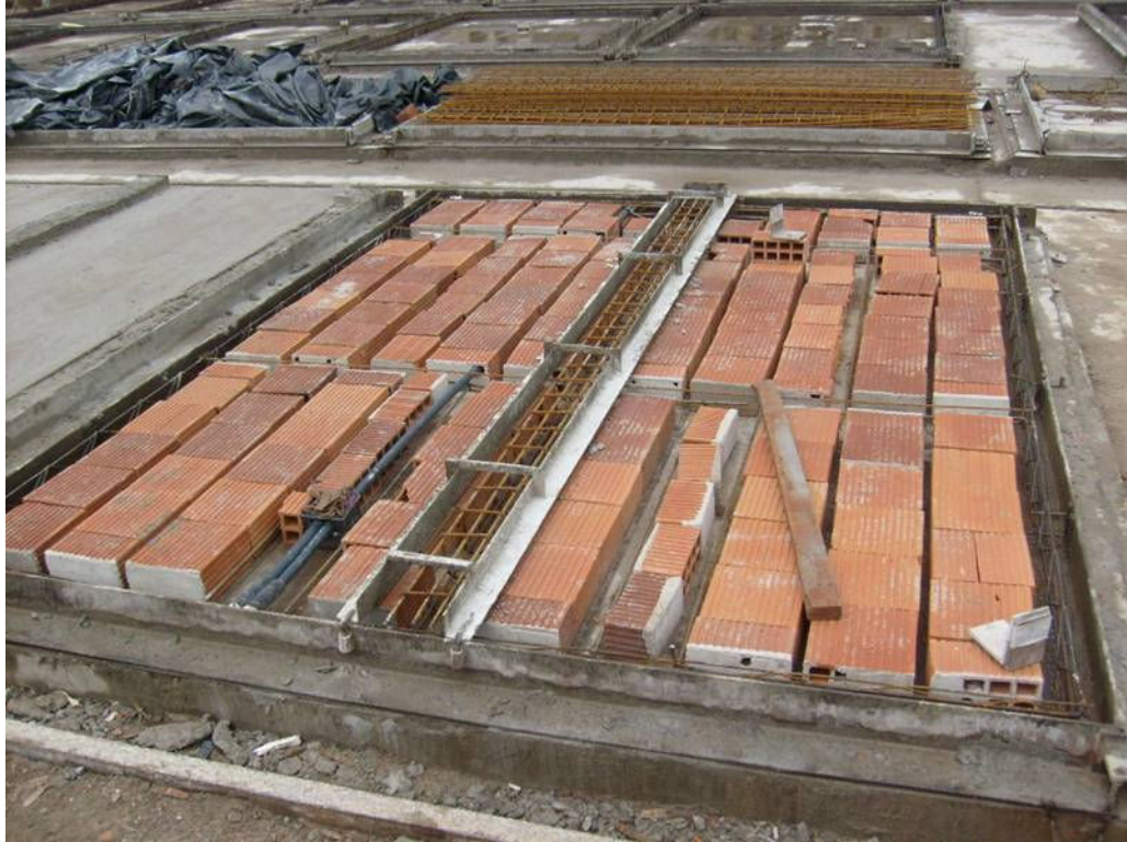
Figura 20: Painel parede a espera da concretagem, mostrando o kit elétrico.
