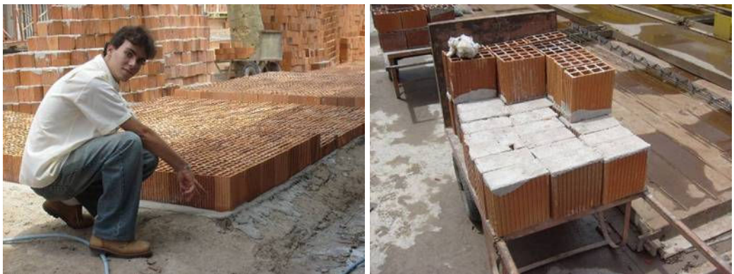
Figura 26: Blocos cerâmicos fechados verticalmente com argamassa.
