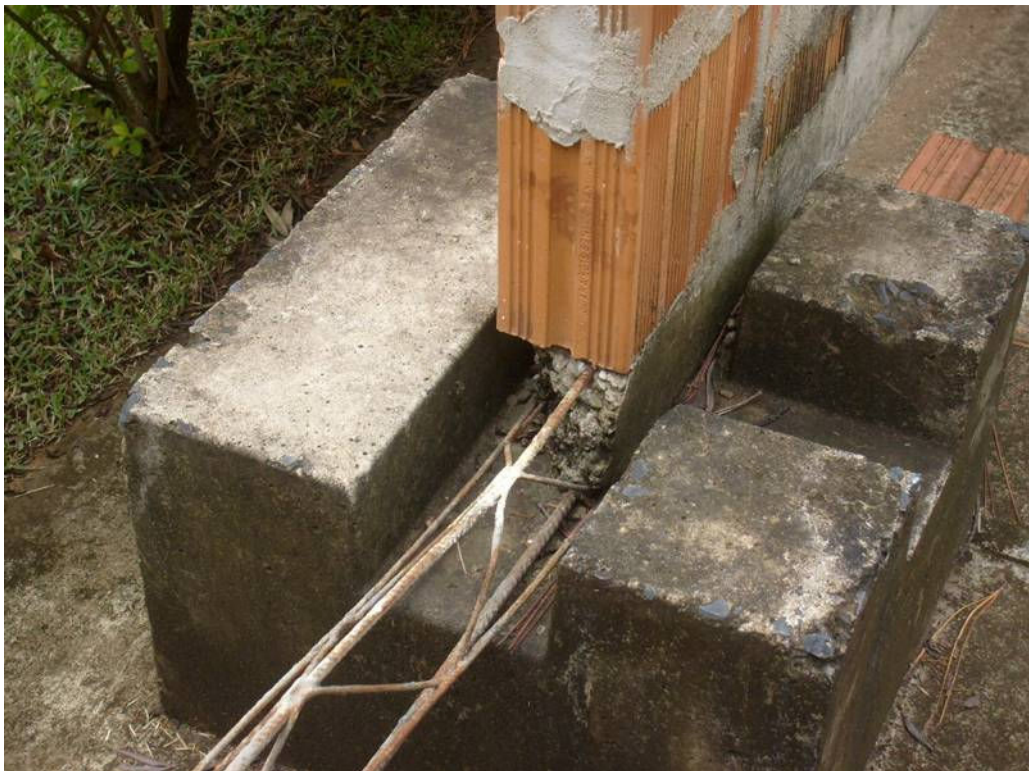
Figura 3: Detalhe do painel sobre o bloco.
